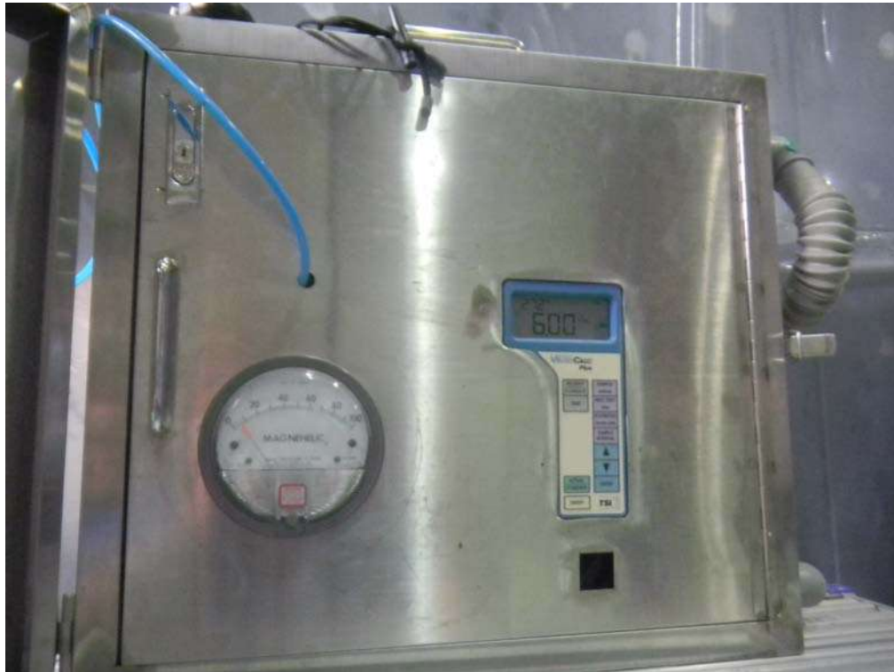
<사진> air leakage test<MAIN DOOR>
